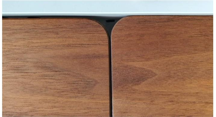
Foto oben: Die Einlegeplatte verläuft nicht genau in der Flucht der Tischplatte und muss etwas einjustiert werden.
